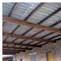
Plaques ondulées en amiante-ciment
