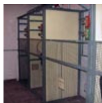
Logettes pare-étincelles en amiante-ciment
